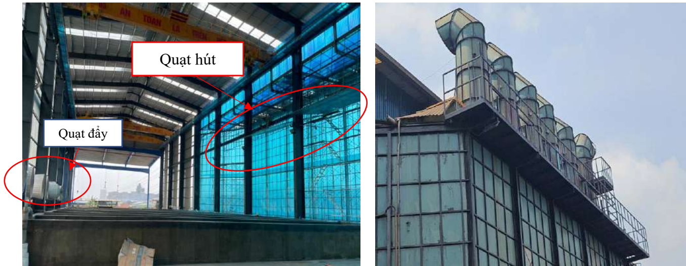
Hình 3.5. Quy trình xử lý hơi hóa chất từ công đoạn tiền xử lý (hơi acid HCl)
