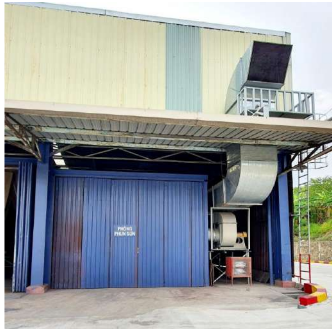
Hình 3.9. Hình ảnh hệ thống thu gom xử lý bụi, hơi dung môi từ công đoạn sơn
