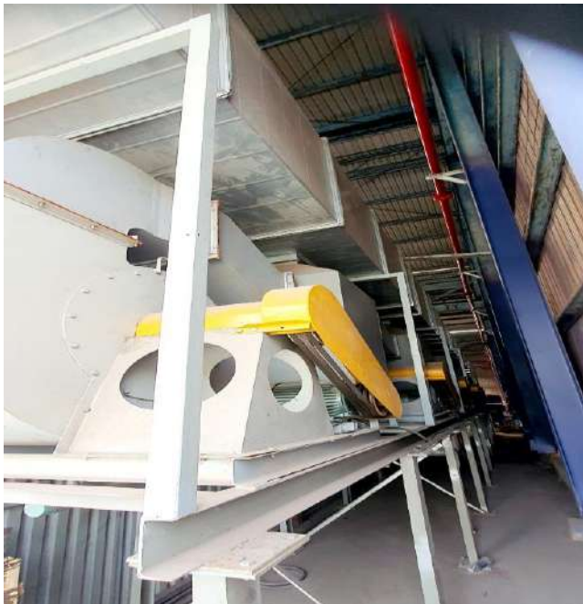
Hình 3.9. Hình ảnh hệ thống thu gom xử lý bụi, hơi dung môi từ công đoạn sơn
